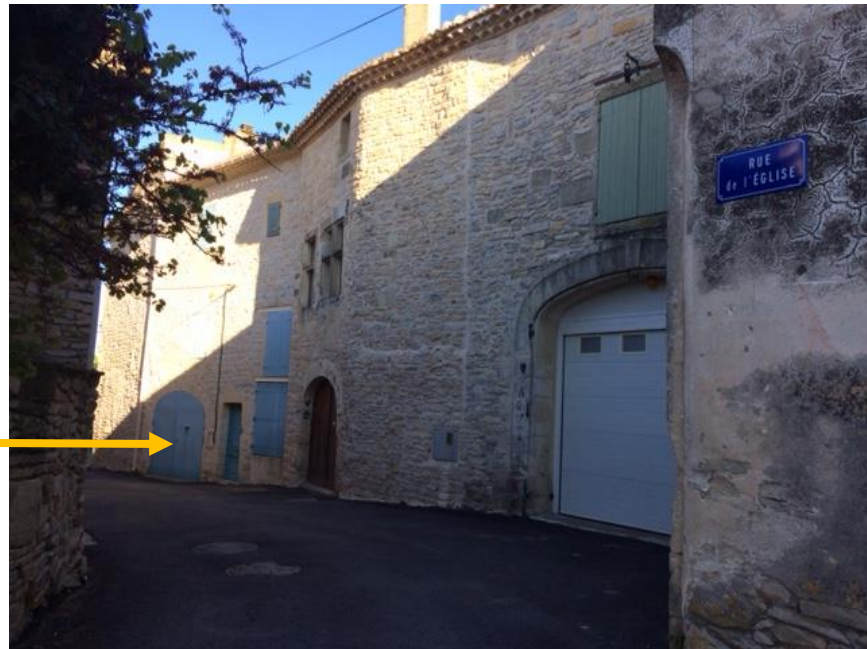
Maison de Jeanne Albouy, 8 rue de l'église
