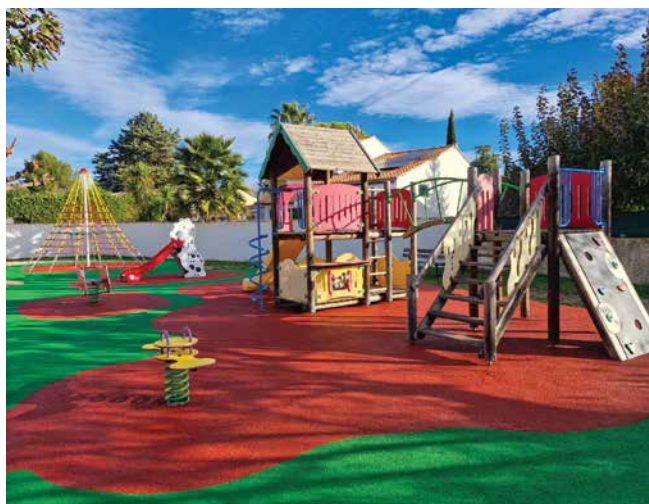
Aire de jeux de Bizac : réfection complète de l'aire de jeux
