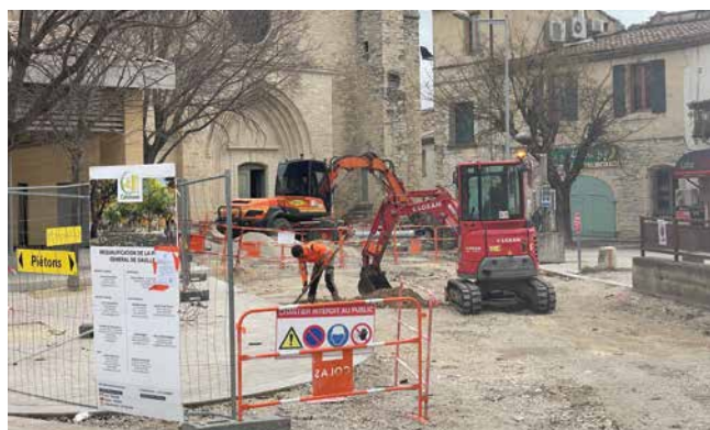
Rue du foyer, place Baroncelli : réfection de la voirie.
