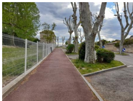
Elargissement du cheminement existant de l'ordre de 0,8/1,0 m, réorganisation des places de stationnement en position longitudinale ► Liaison piéton / cycle avec la voie verte élargie, mieux identifiée
