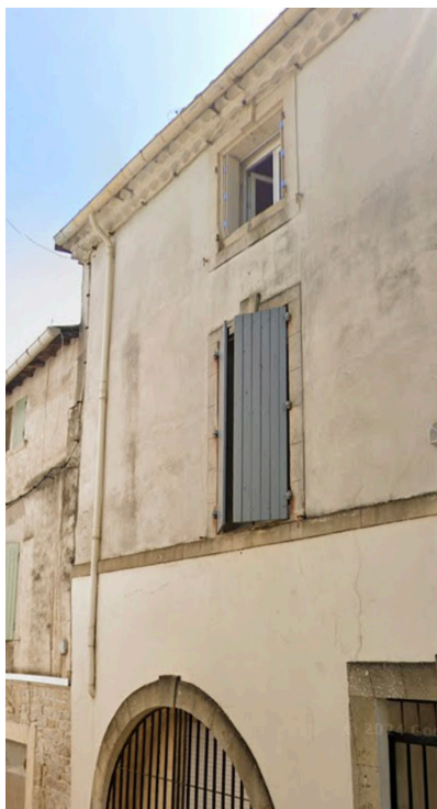
49, Grand Rue. Exemple d'une façade couvrante destinée à être enduite. Les encadrements de portes, de fenêtres et les bandeaux de façade sont en saillies et en pierre de taille.
