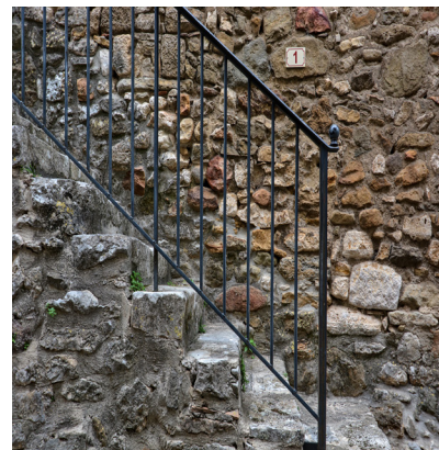
Le barreaudage ajouté doit être vertical et simple
