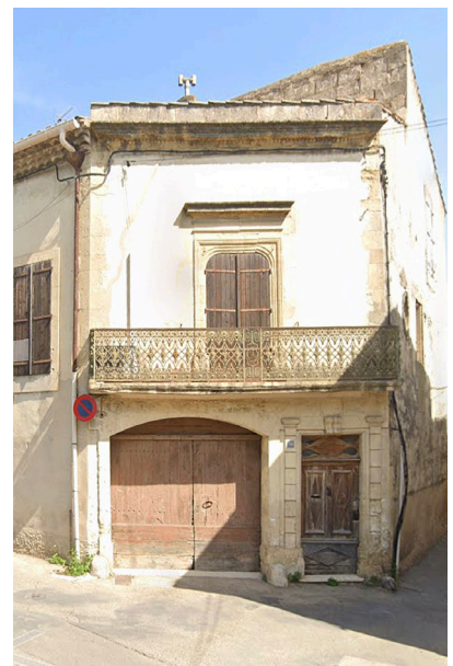
Exemple de balcon à conserver avec garde-corps en fonte. Rue Baratier/rue Bourrely
