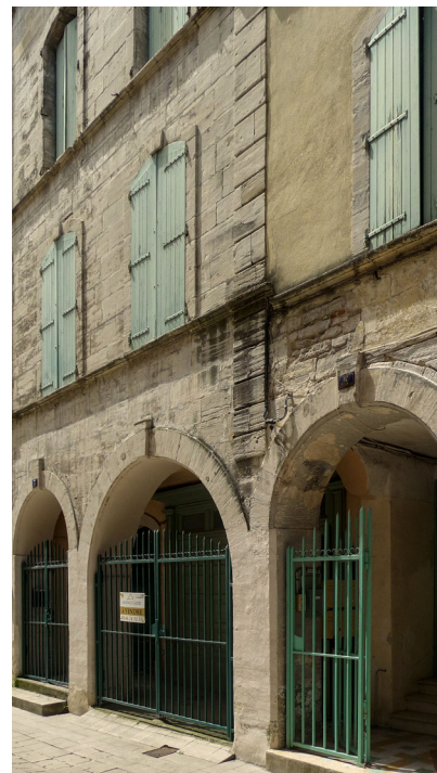
Exemple d'une façade nécessitant un ravalement d'entretien.
