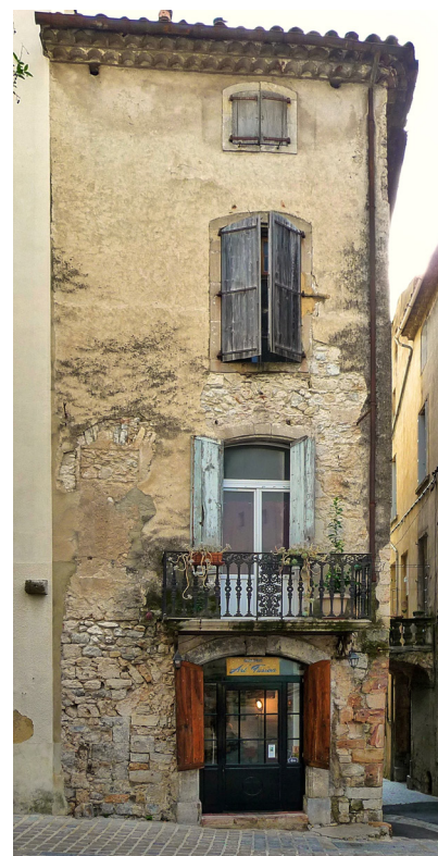
Exemple d'une façade nécessitant un ravalement complet.
