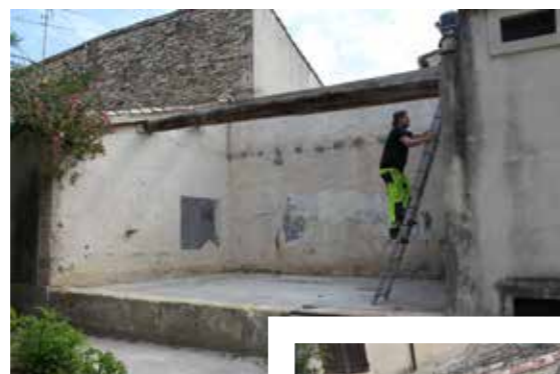
Dans la cour extérieure de la maison, un bâtiment devenait dangereux, les agents des services techniques ont sécurisé les lieux en enlevant la toiture et un mur.
